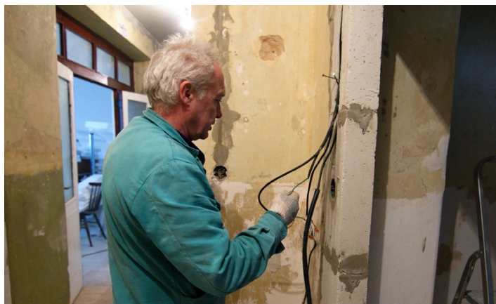
Vladimír Stolár vymieňa elektroinštaláciu v celej budove. foto: vv
