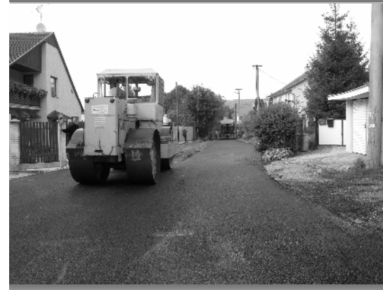
Rekonštrukcia miestnej komunikácie Podhorská ulica - pokládka asfaltového koberca.
