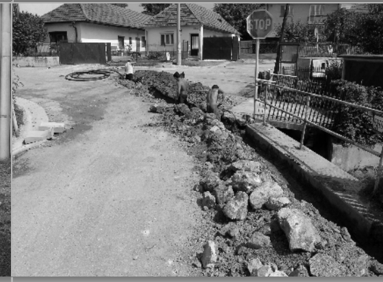
Vybudovanie vodovodnej prípojky na Podhorskej ulici.
