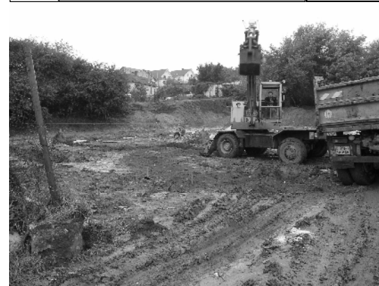
Začiatok výstavby 16-tich dvojizbových bytov v obci Banka s predpokladaným ukončením v novembri 2006 a plánovaným rozpočtom 18 mil Sk.
