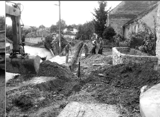
Rekonštrukcia prípojky vodovodu na Poľnej ulici.
